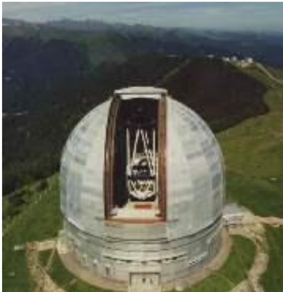
БТА – Большой телескоп Академии наук, Северный Кавказ, 1975 год Диаметр зеркала – 6 м
